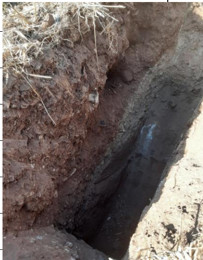
Vue d'ensemble de la fouille
