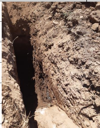
Vue d'ensemble sur la fouille
